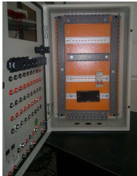
Figura 3.44: Montaje de elementos
