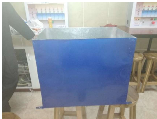
Figura 3.55: Construcción del depósito del sistema biestable de presión
