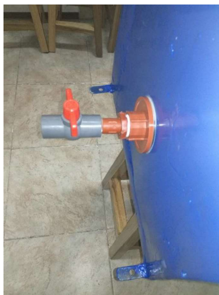
Figura 3.58: Fijación de la válvula tipo bola de plástico al depósito.
