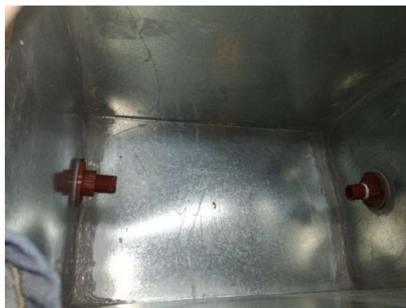
Figura 3.56: Implementación de adaptadores de tanque al depósito
