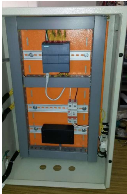
Figura 3.49: Colocación de cubiertas sobre la canaleta ranurada
