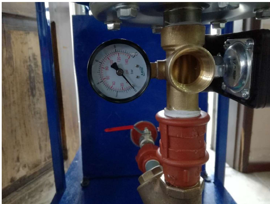
Figura 3.62: Instalación del sistema hidroneumático
