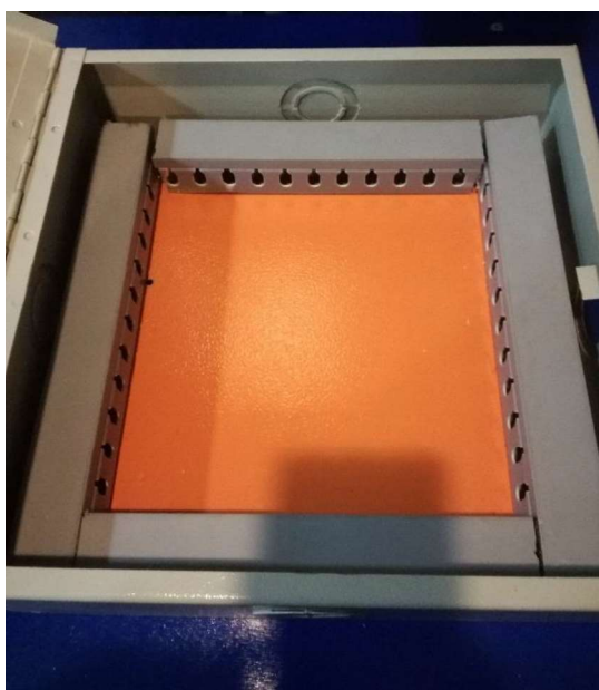
Figura 3.66: Instalación de canaleta ranurada dentro de los gabinetes
