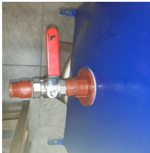
Figura 3.57: Fijación de la válvula tipo bola de metal al depósito.
