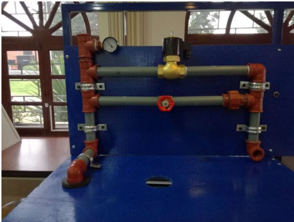
Figura 3.63: Fijación de la electroválvula y válvula tipo compuerta a la estructura
