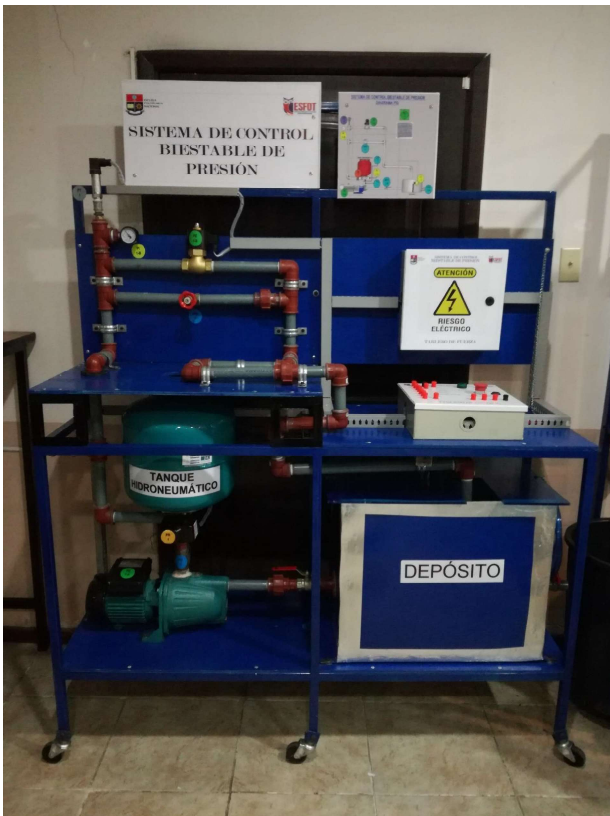
Figura 3.81: Acabado final del sistema biestable de presión
