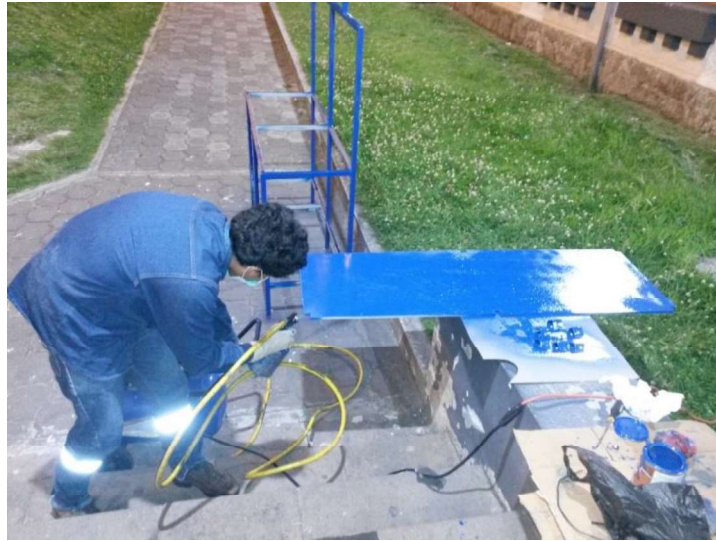
Figura 3.53: Renovación de la estructura para el sistema biestable de presión
