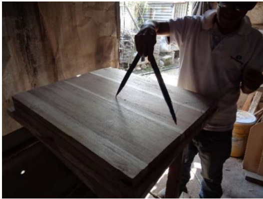
Figura 2.34. Construcción de las paredes hexagonales. (Fuente: Propia)
