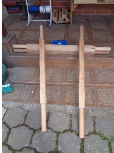
Figura 2.32. Construcción de los ejes.
