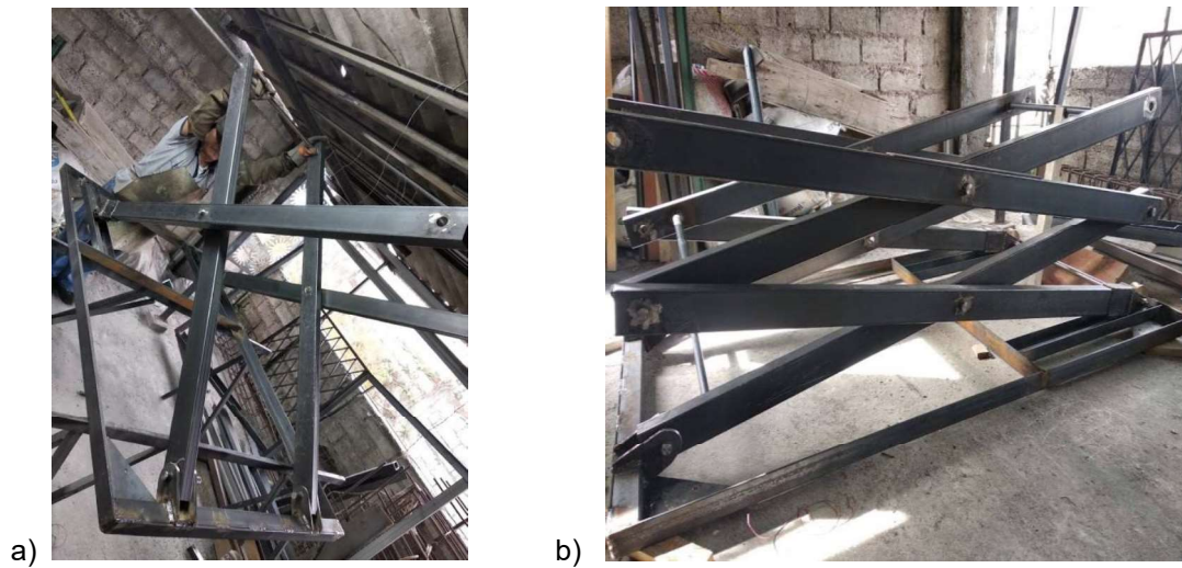
Figura 2.41. (a) Armado del primer par de tijeras. (b) Armado del segundo par de tijeras
