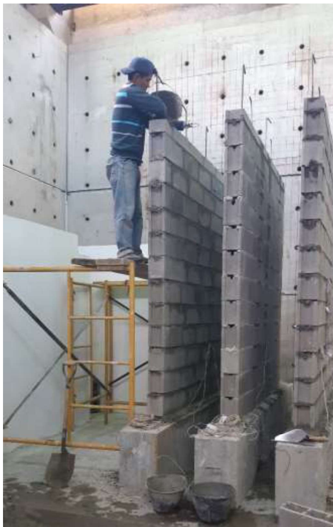
Foto 9: vertido de hormigón líquido
