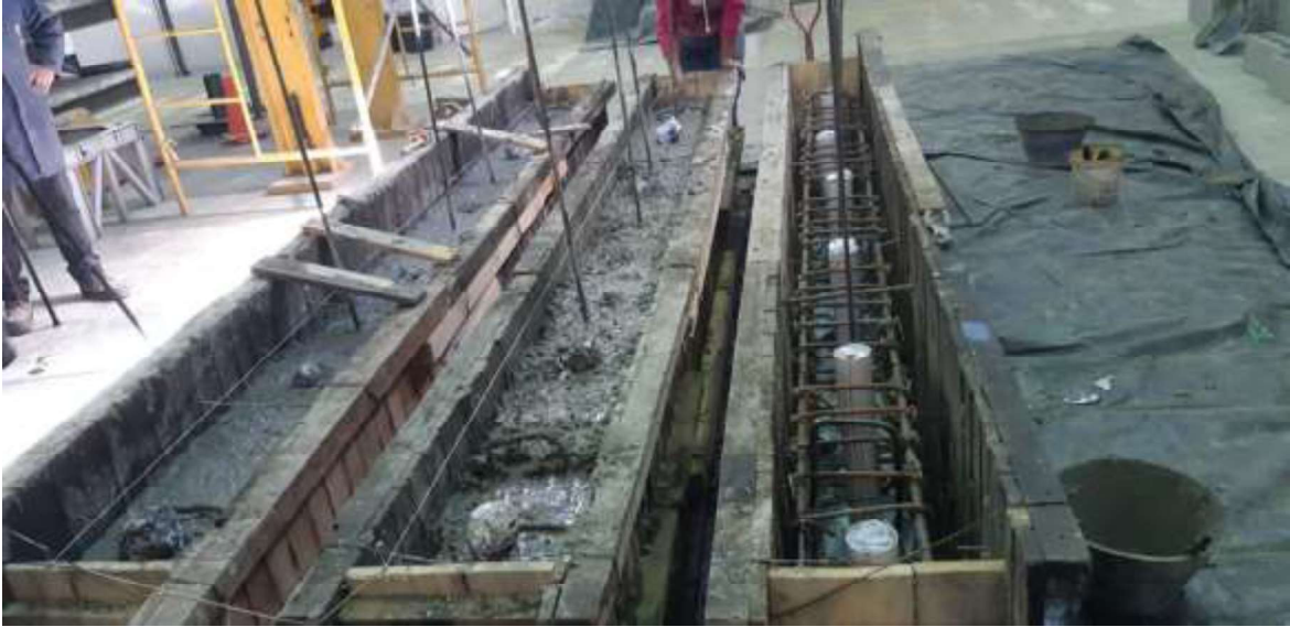
Foto 5: Fundición de las vigas de cimentación
