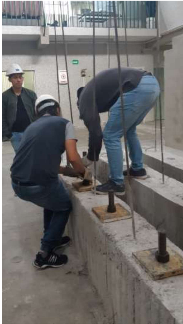
Foto 7: colocación de pernos de anclaje
