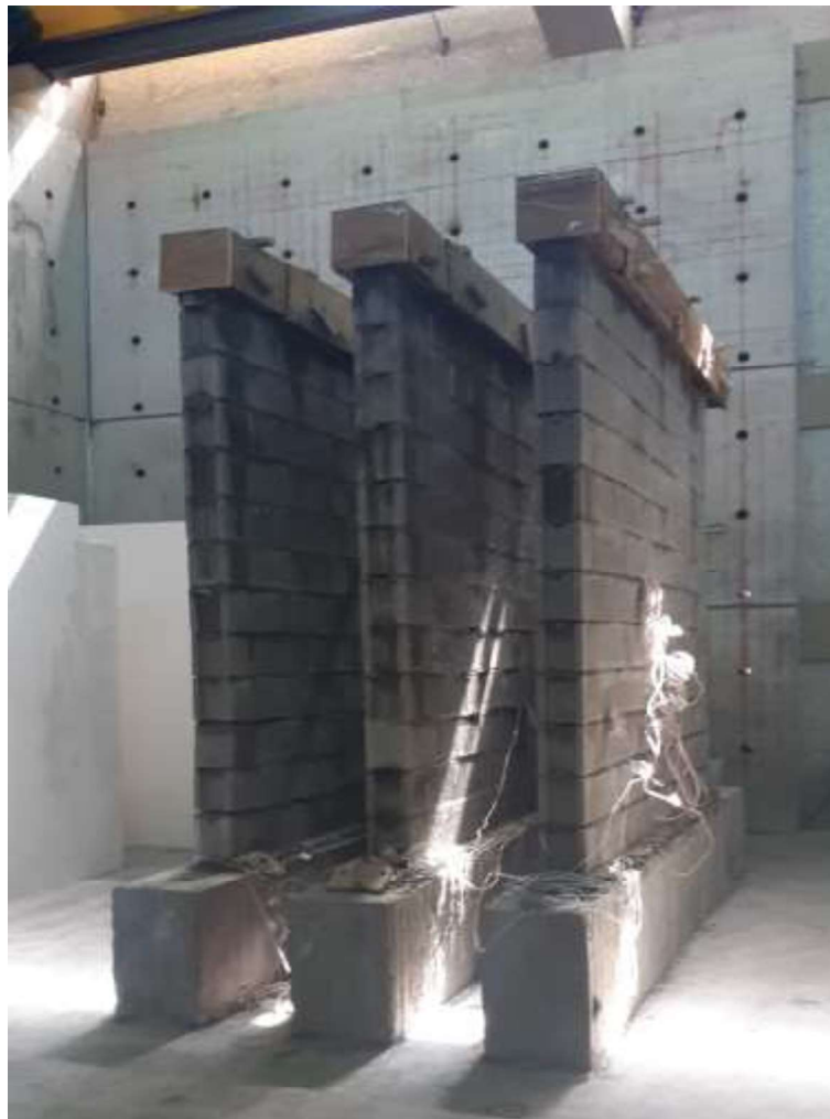
Foto 12: Muros de mampostería terminados
