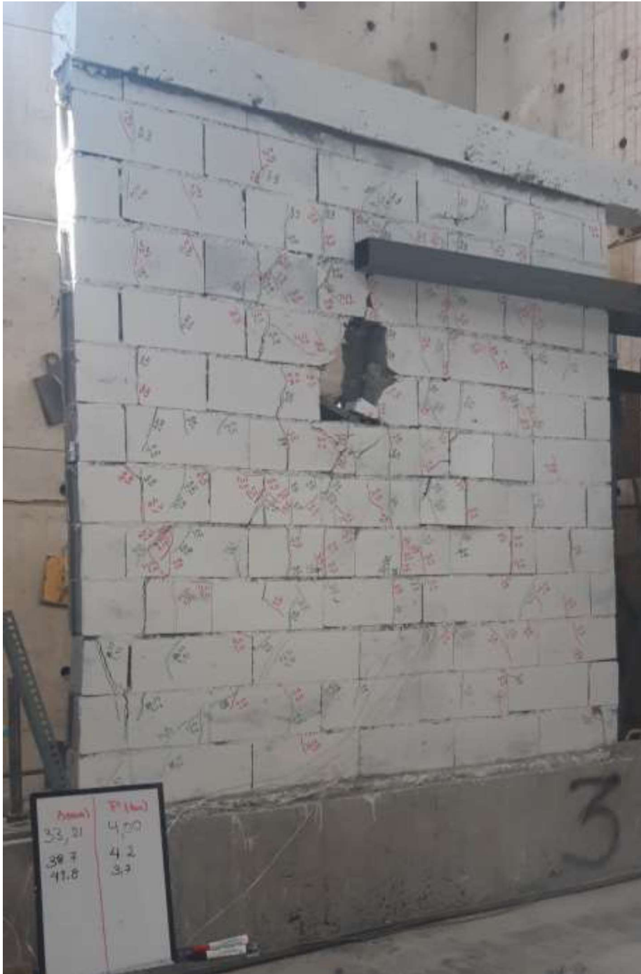
Foto 15: Tercer muro, ensayo terminado
