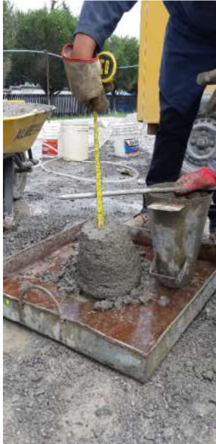
Foto 16: verificación del asentamiento del hormigón
