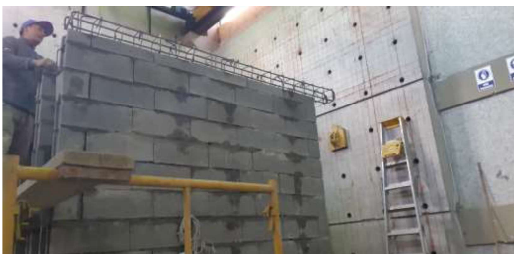
Foto 10: Colocación del armado de la riostra
