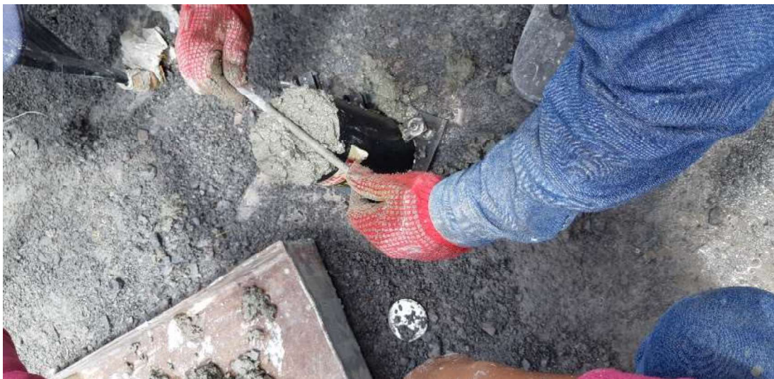
Foto 17: Toma de cilindros para ensayo de resistencia
