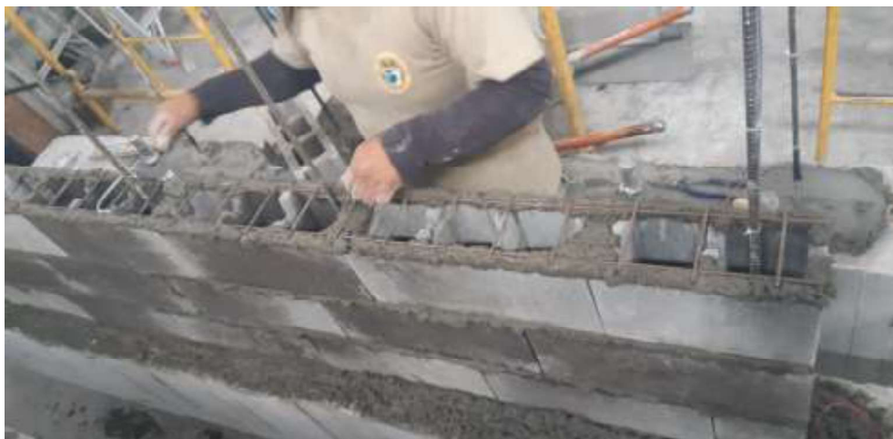
Foto 8: Levantamiento de la mampostería
