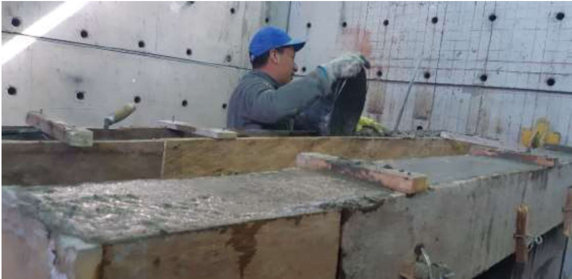
Foto 11: Fundición de las riostras
