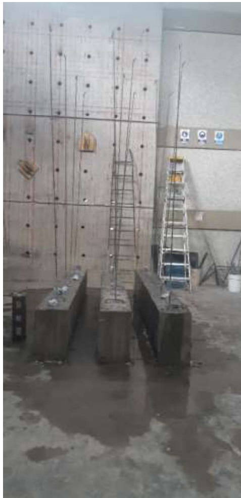
Foto 6: Curado de las vigas de cimentación
