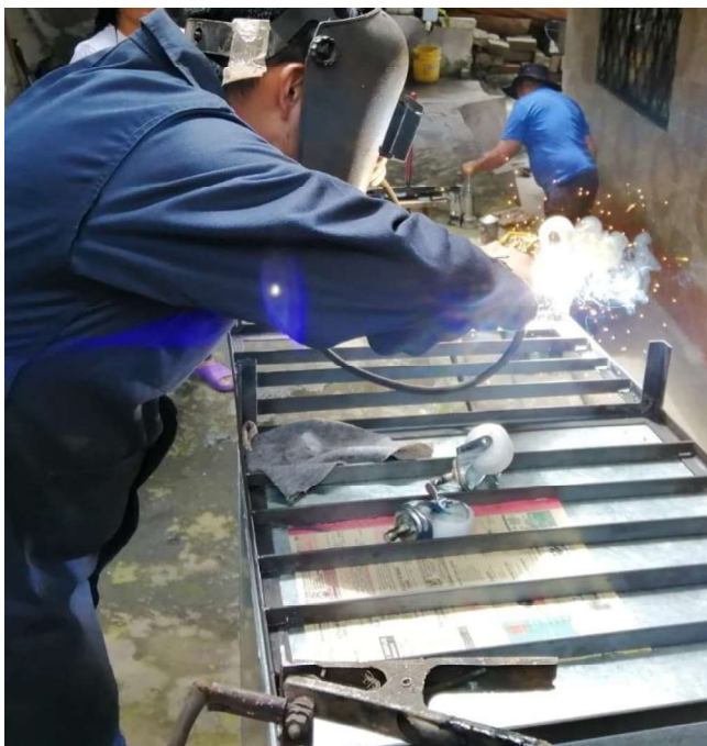
Figura 3.23. Proceso de suelda eléctrica. Fuente propia.
