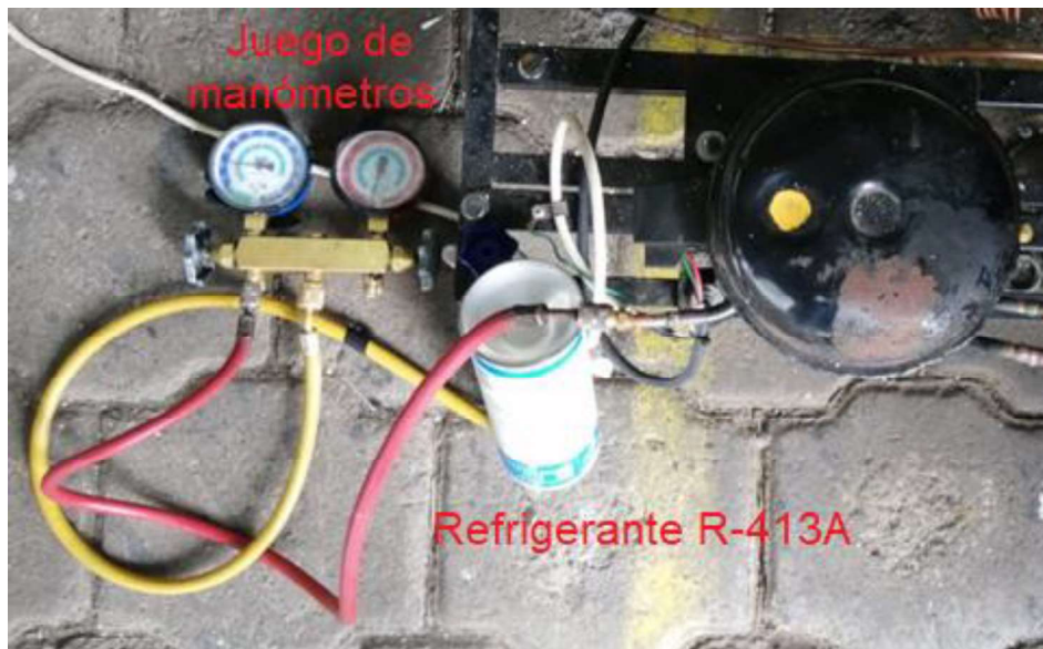
Figura 3.36. Carga del refrigerante R-413A al sistema. Fuente propia.
