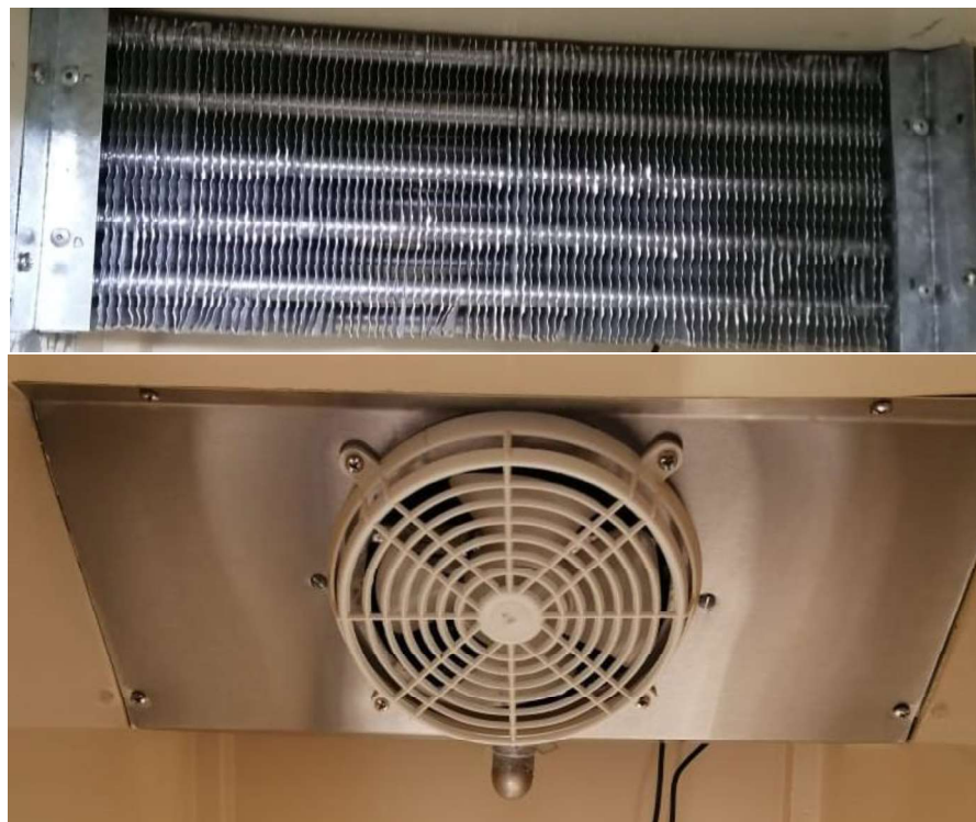
Figura 3.14. Evaporador aletado y protector con ventilador. Fuente propia.
