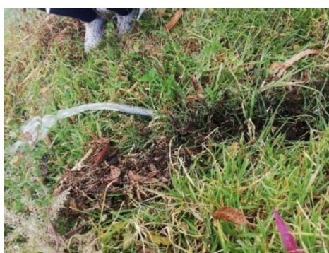
Figura 23 Válvula de desagüe Fuente: El autor, 2019
