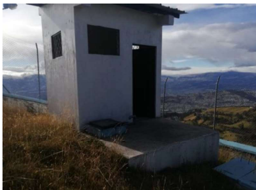
Figura 17 Tanque de Almacenamiento-Tratamiento Fuente: El autor, 2019
