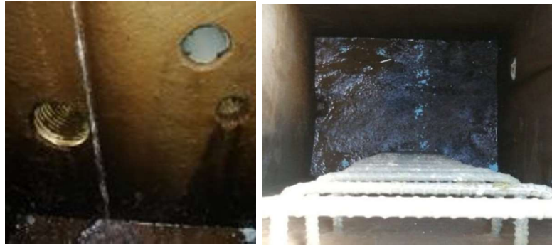
Figura 21 Tuberías de desagüe Fuente: El autor, 2019
