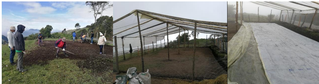
a) Limpieza b) Estructura de madera c) Colocación de plástico
