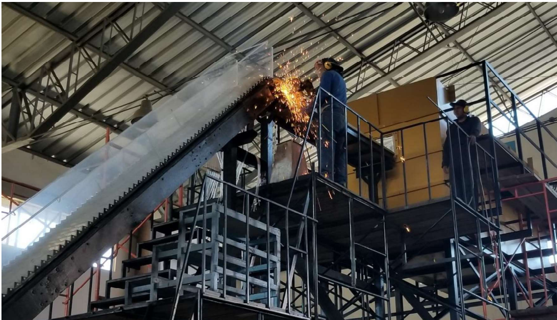
Fotografía No. 10: Fijación de la estructura metálica de soporte del canal externo de aproximación hacia la rápida escalonada.
