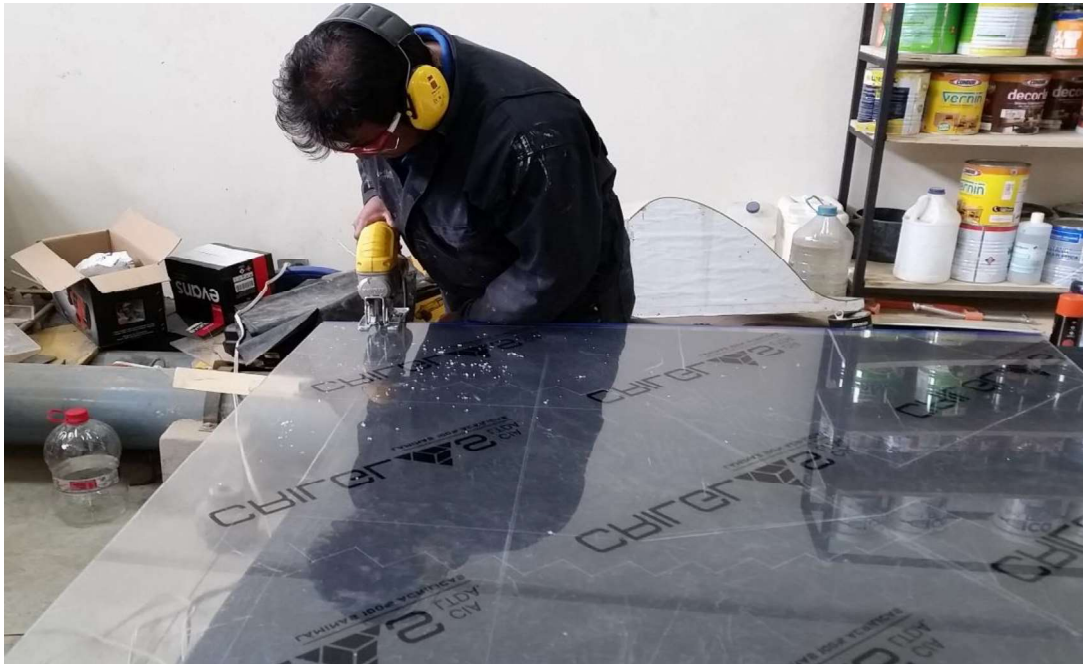
Fotografía No. 26: Fabricación de los componentes de la pieza del perfil curvo escalonado para la geometría modificada M2.
