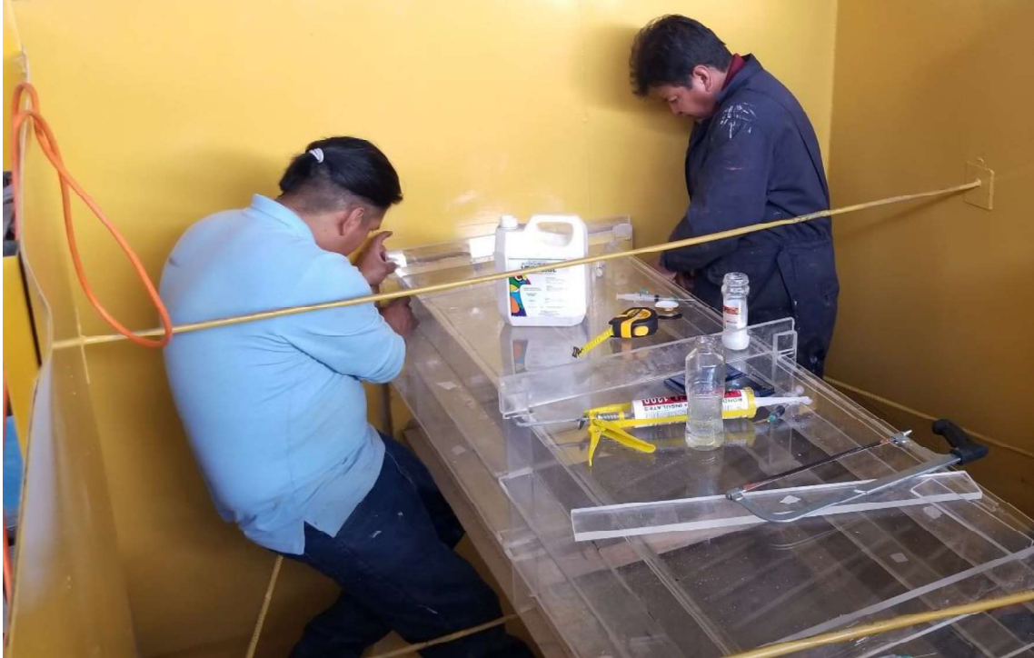
Fotografía No. 5: Sellado del canal de ingreso dentro del tanque de abastecimiento.
