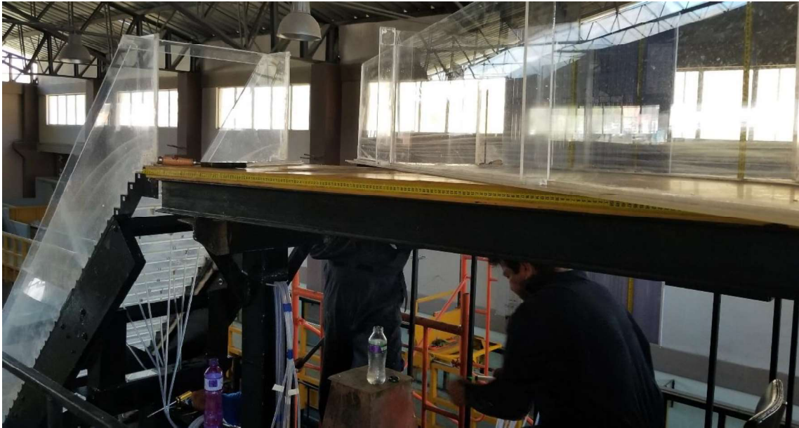
Fotografía No. 11: Colocación del canal externo de aproximación.
