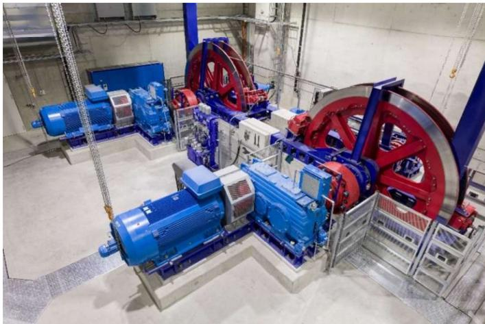
Figura 1.4. Sistema motriz teleférico Zugspitze, Alemania.
