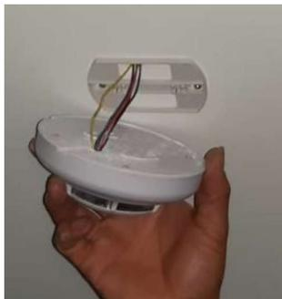
Figura 3.21: Sujeción de sensor de humo.
