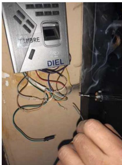
Figura 3.6: Conexiones del Lector Biométrico
