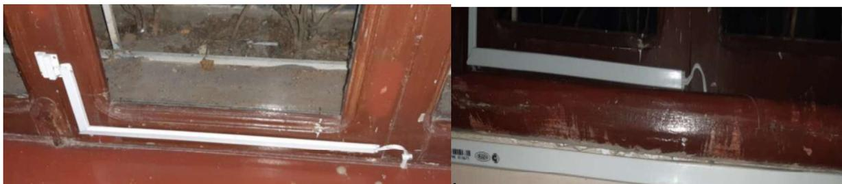
Figura 3.17: Instalación de sensores magnéticos en las ventan y marcos.
