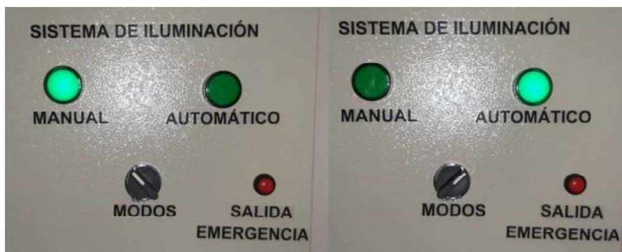
Figura 3.25: Accionamientos del selector
