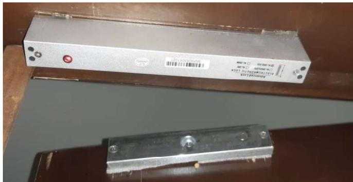
Figura 3.7: Fijación de cerradura electromagnética
