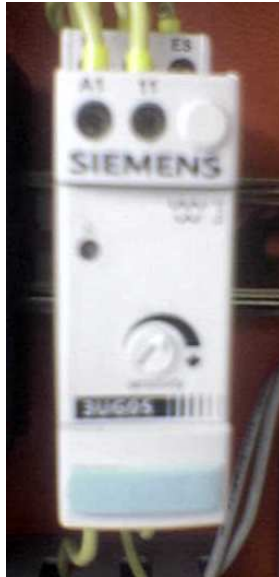
Figura 2.12 Supervisor de nivel.
