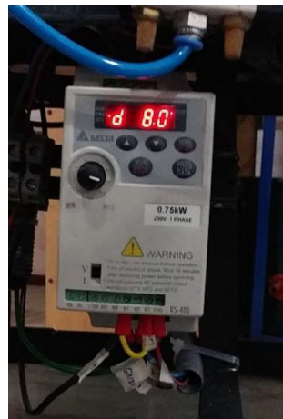
Figura 3.52: Instalación del variador de frecuencia.
