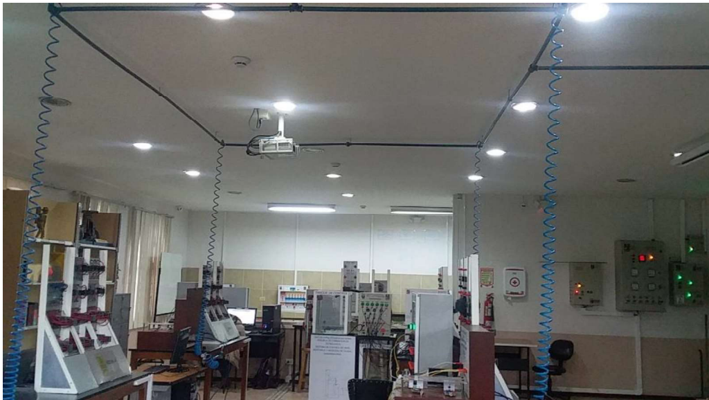
Figura 3.68: Sistema de distribución de aire comprimido.
