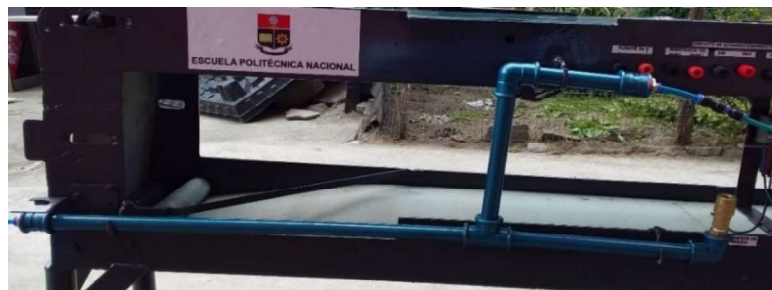
Figura 3.53: Instalación del tubo PVC de ½”.
