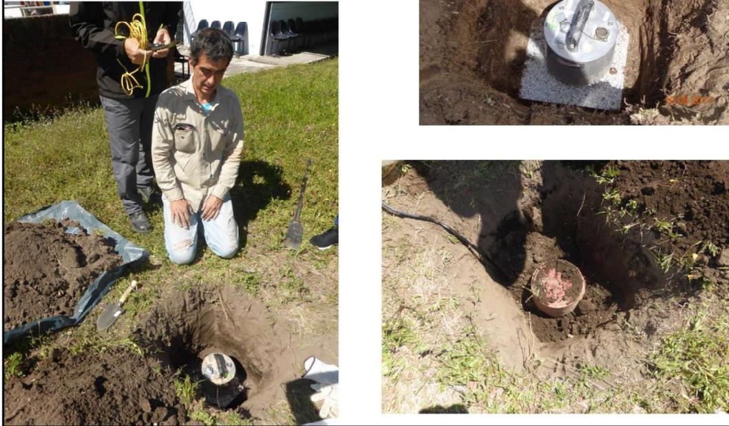
**Figura 4.2** Ejemplos de cómo se instalaron los sensores.
