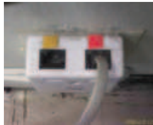
Figura No. 1.3 Cajetín con salida doble para red de voz y datos
