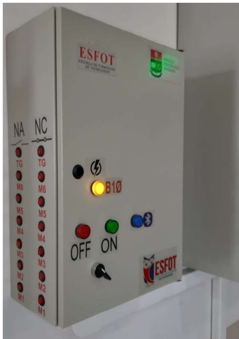
Figura 3.1. Tablero construido. (Fuente: Propia)
