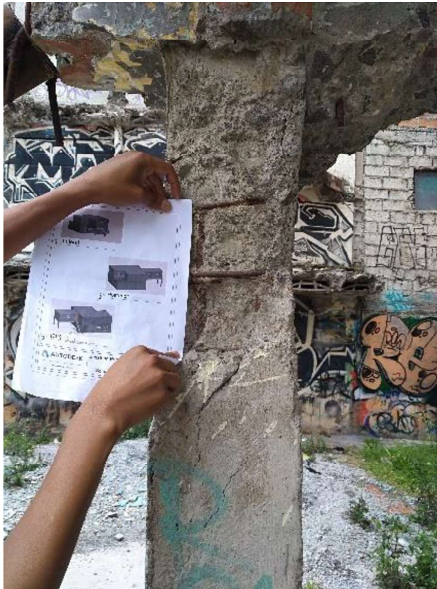
Figura 30- Separación de 10 cm en extremos de la columna.
