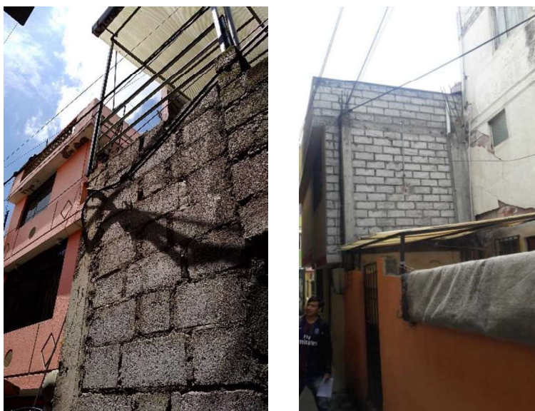
Figura 16-Refuerzo en ampliaciones sin acabados.
