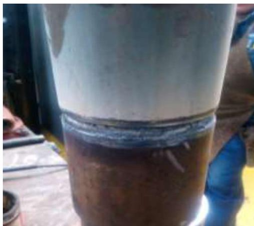
Figura 2.12. Realización de los pases de soldadura.
