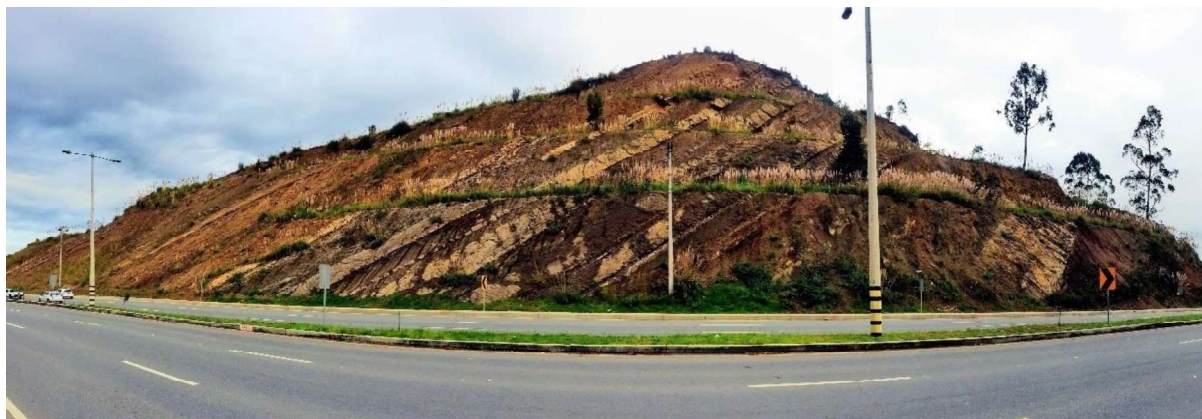
Figura 21. Afloramiento de la Formación Azogues (UTM: 0737615/9693227). Ver figura 22 para detallar la columna estratigráfica de este afloramiento.
