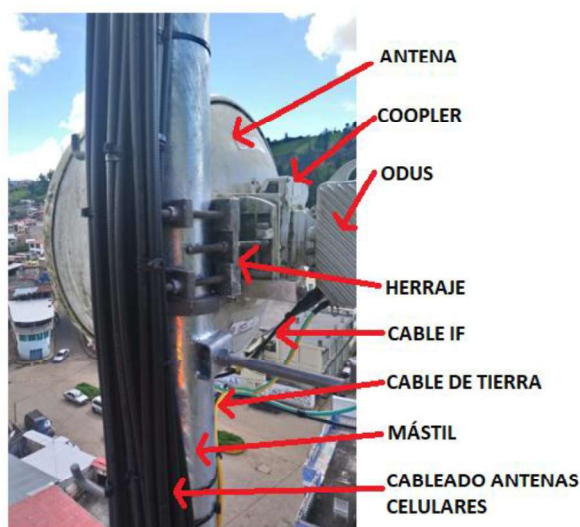
Figura 2.40. Elementos enlace microonda outdoor.
