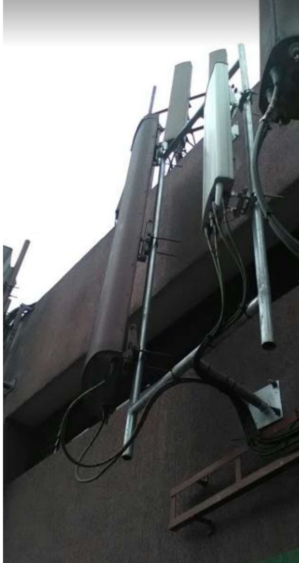
Figura 1.30. Soportes en fachadas.
