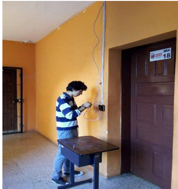
Figura 3.34: Conexión de los cables del biométrico
