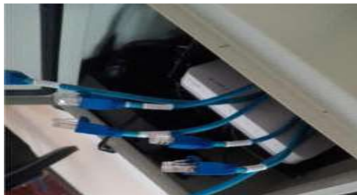
Figura 3.28: Terminación del cable UTP
