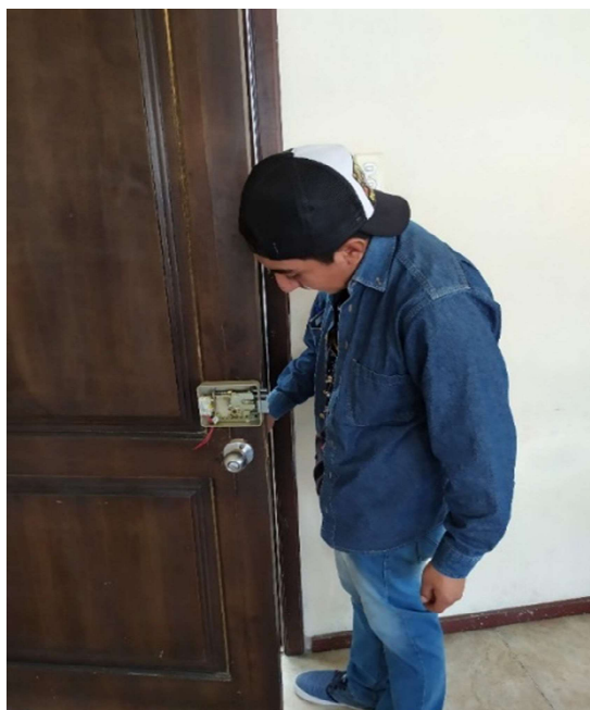
Figura 3.32: Instalación de la cerradura eléctrica
