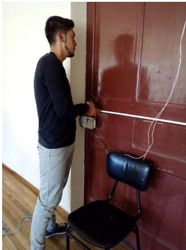
Figura 3.21 Instalación de chapas eléctricas
