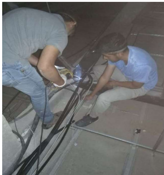
Figura 3.14 Puesta de mangueras para proteger los cables
