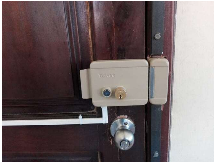
Figura 3.22 Protección de los cables de la chapa eléctrica
