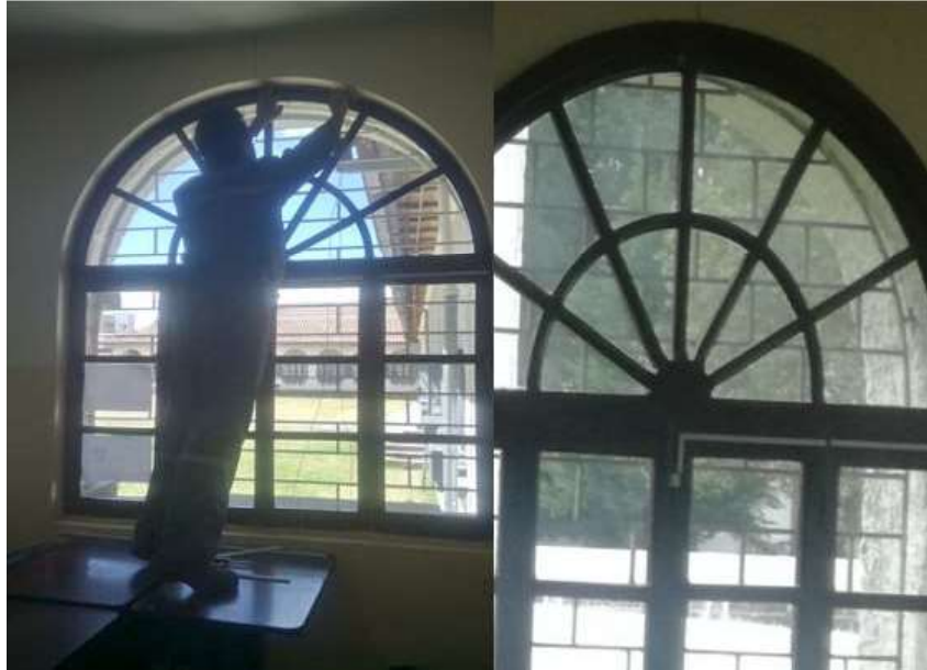
Figura 3.15 Colocación de sensores en las ventanas
