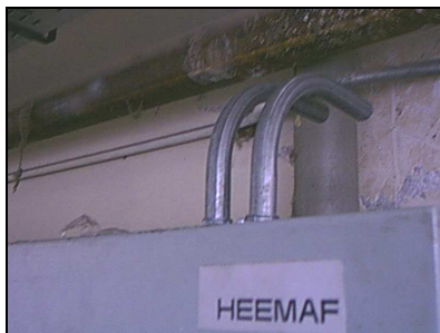
Figura 3.8 Instalación de tubería para el transporte de nuevas conexiones
