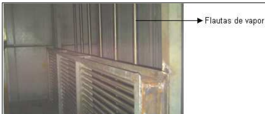
Figura 1.19 Flautas que inyectan vapor
