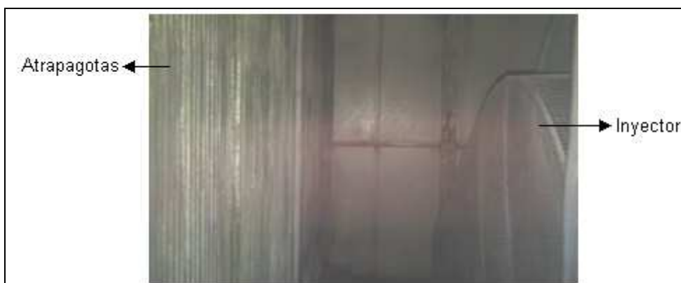
Figura 1.20 Láminas que quiebran el flujo del aire para retener gotas de agua
