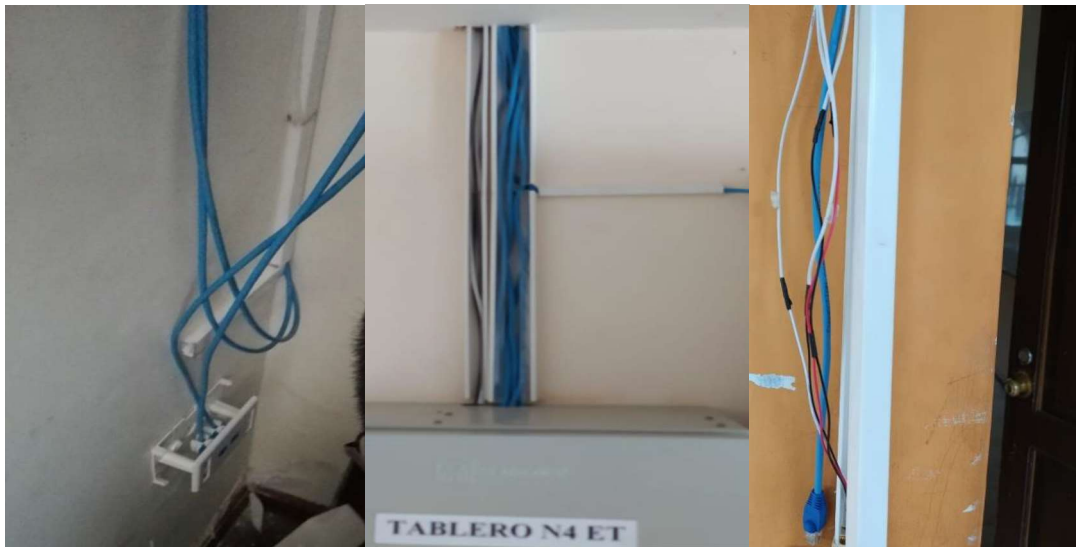
Figura 3.15 Instalación de cajas y canaletas, servidor, tablero ET, biométrico.
