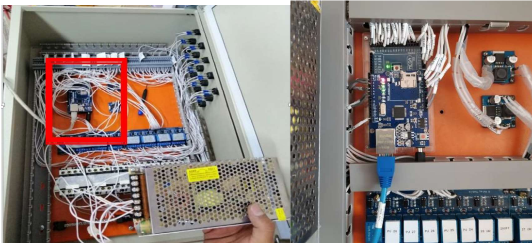
Figura 3.20 Instalación de placa Arduino Mega 2560 en tablero EM
