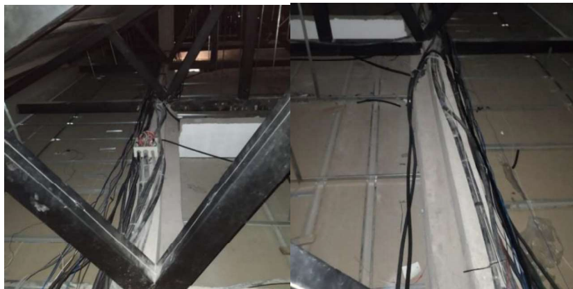
Figura 3.14 Instalación del cableado UTP y alimentación
