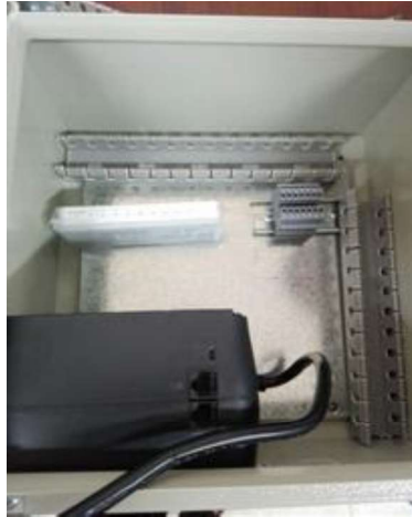
Figura 3.13 Montaje del tablero ET
