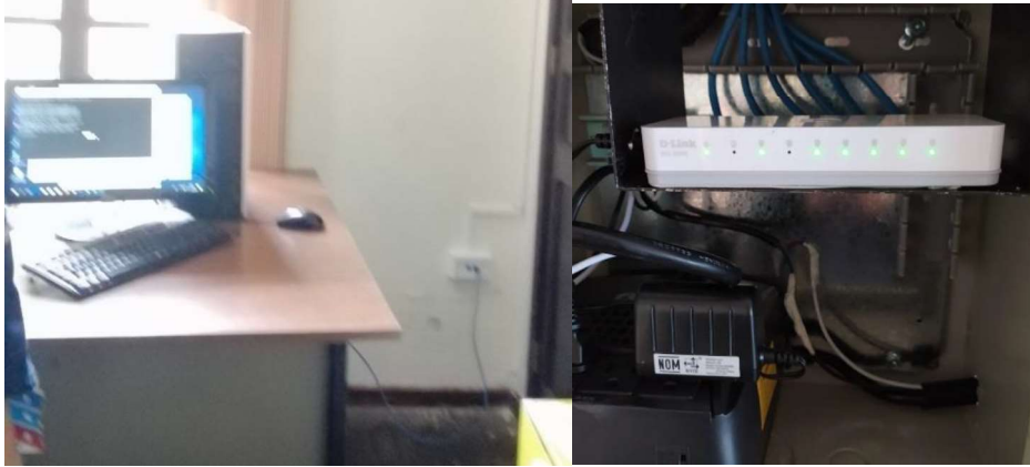
Figura 3.17 Instalación de equipos
