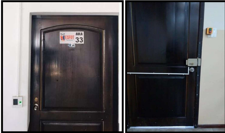
Figura 27. Biométrico de control de acceso, instalación de chapa y pulsador aula 33
