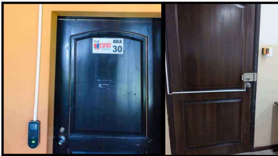
Figura 25. Biométrico de acceso e instalación de chapa y pulsador aula 30
