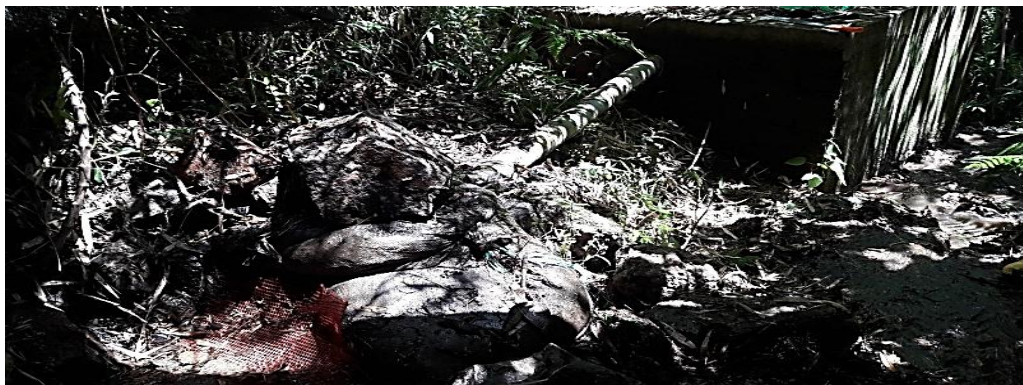
Figura 35. Tubería de Captación
