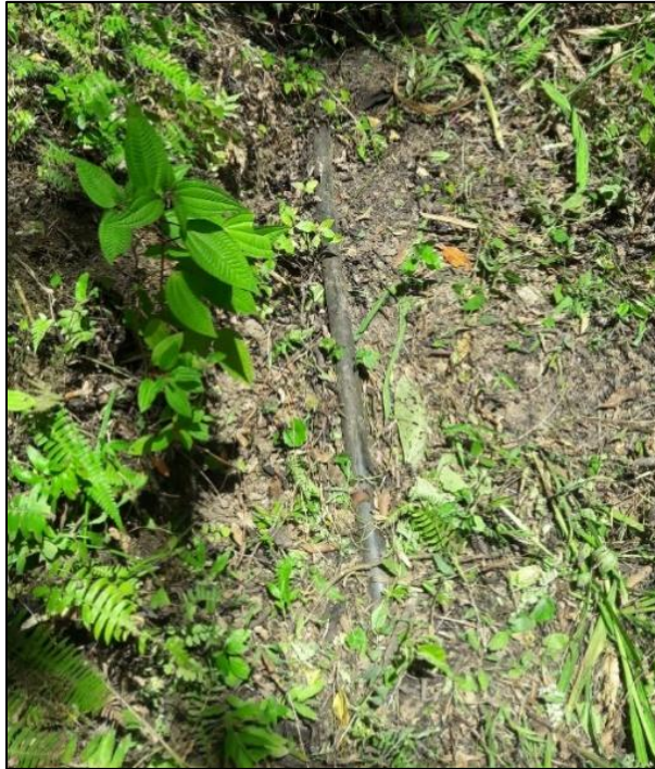
Figura 36. Manguera de Conducción Expuesta
