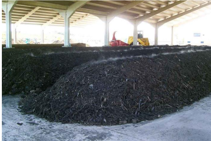
Figura 17. Vista de la planta de compostaje en Mallorca (España)
