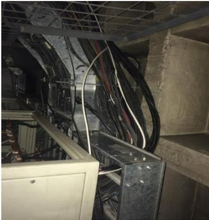
**Fig. 3.7 Mala distribución de cableado de tableros**
