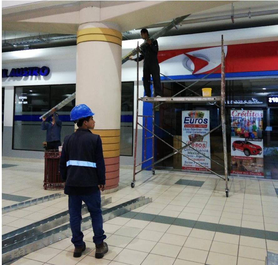
**Fig. 6.52 Cambios de bandejas para cableado nuevo en las instalaciones eléctricas del centro comercial El Recreo**
