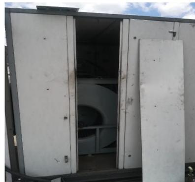
**Fig. 3.10 Motor Humidificador usado como extractor de aire en patio de comidas**
