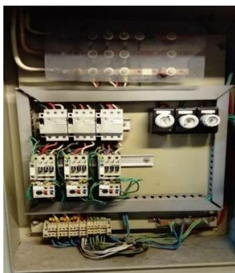
**Fig. 3.11 Tablero de control de accionamiento de 3 motores de servicios auxiliares para saneamiento de ETAPA I**
