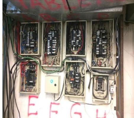
**Fig. 3.6 Tableros desordenados y en mal estado**
