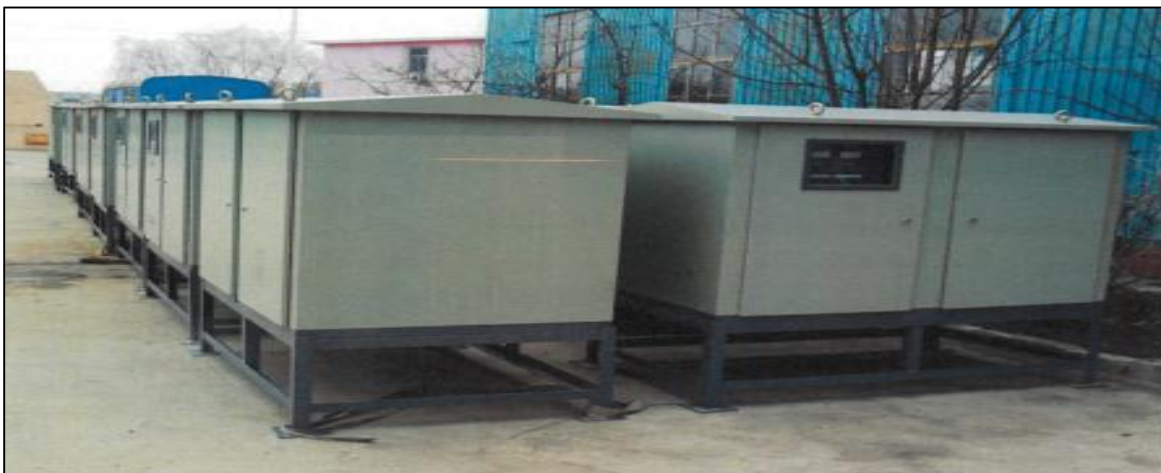
GRÁFICO 3.2 TRANSFORMADOR DE VOLTAJE
