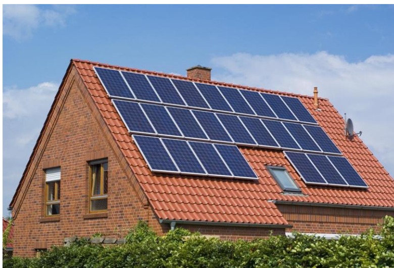
Figura 1.16. Paneles solares en vivienda
