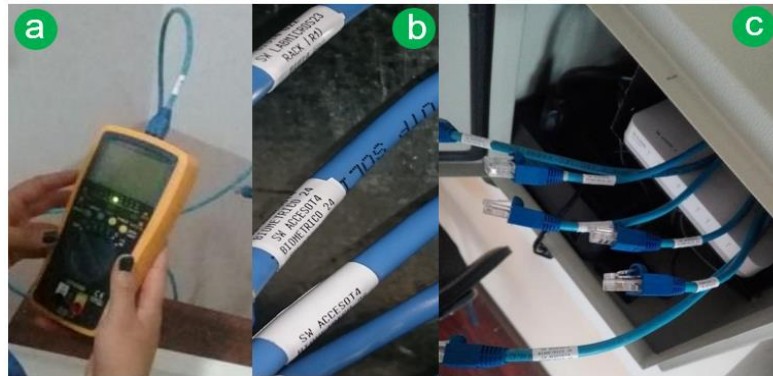
Figura 3.16 Ponchado y etiquetado del cable de red del sistema.
