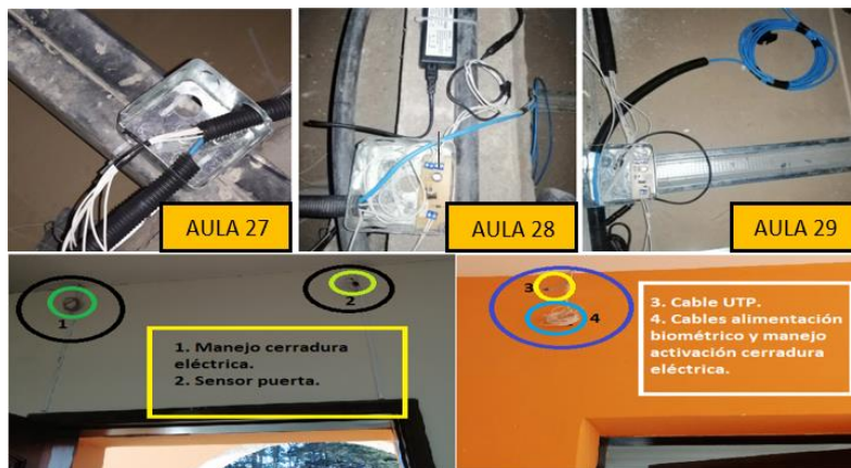
Figura 3.14 Instalación de la tubería que incluye cable de red y eléctrico.
