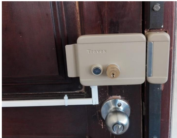
Figura 3.35 Montado de la cerradura eléctrica.
