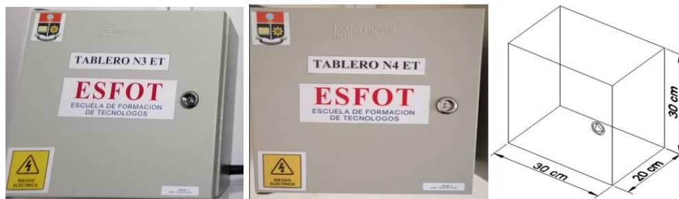
Figura 3.25 Tablero ET N° 3 y N° 4 con sus dimensiones.
