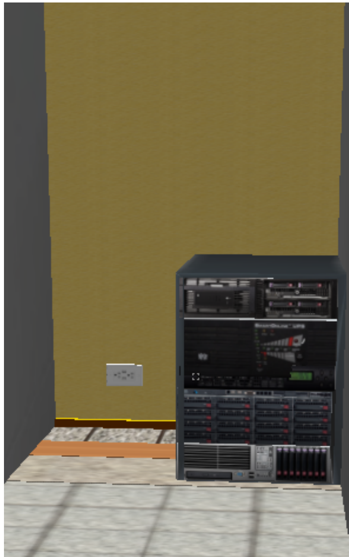
Figura 52: Imagen del cuarto de entrada
