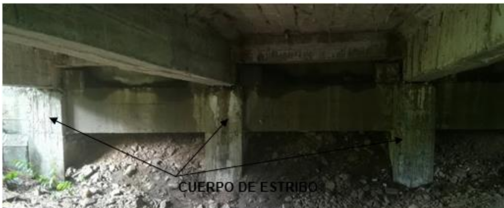
FIGURA 3.11 Cuerpo del estribo del puente
