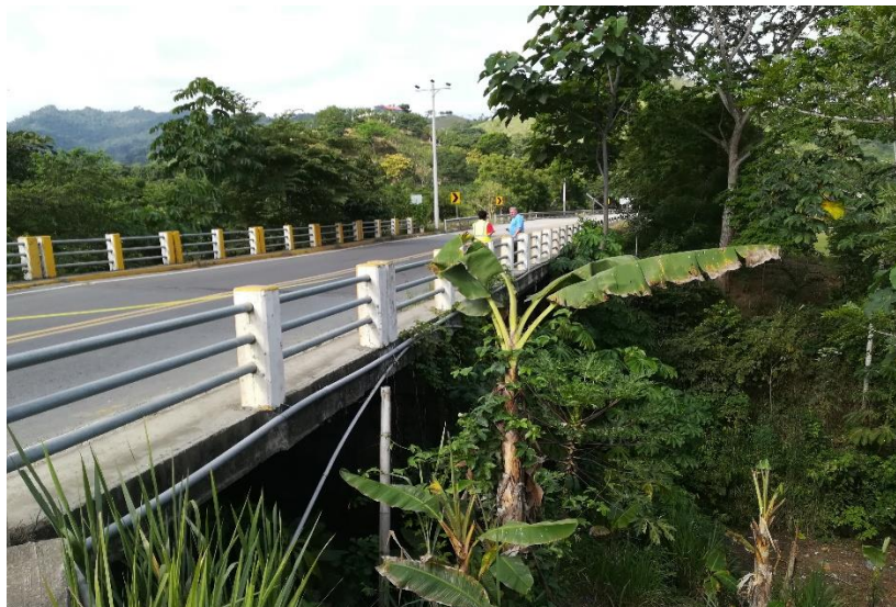
FOTOGRAFIA 3.2 Acera y baranda del puente sobre río Mocora
