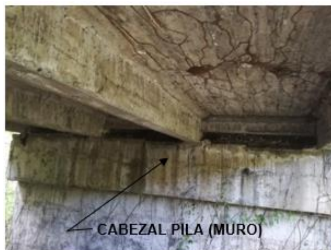
FIGURA 3.9 Cabezal de las pilas del puente
