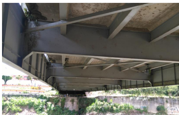
FIGURA 2.13 Diafragmas del Puente
