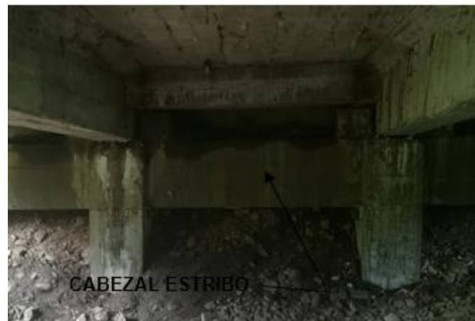
FIGURA 3.8 Cabezal de los estribos del puente
