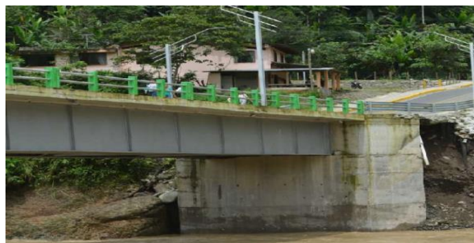
FIGURA 2.5 Estribo de Puente de Pisotanti (Santo Domingo de los Tsáchilas)
