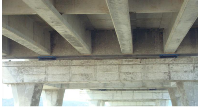
FIGURA 2.4 Aparatos de Apoyo del Puente de Bahía de Caráquez
