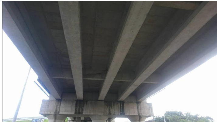
FIGURA 2.12 Vigas Principales del Puente Juan Larrea (Pichincha)
