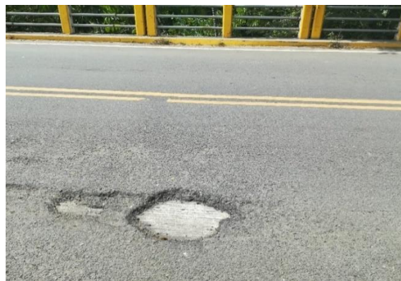
FOTOGRAFIA 3.4 Superficie de rodadura en mala condición
