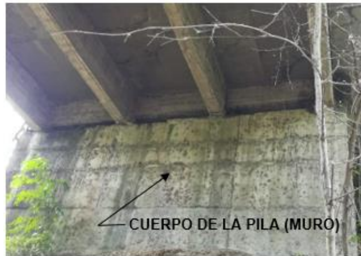
FIGURA 3.12 Cuerpo de la pila del puente
