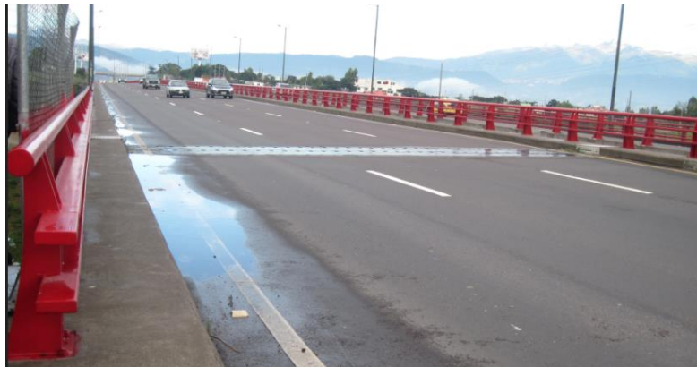
FIGURA 2.8 Calzada del Puente Juan Larrea que atraviesa la Ruta Viva
