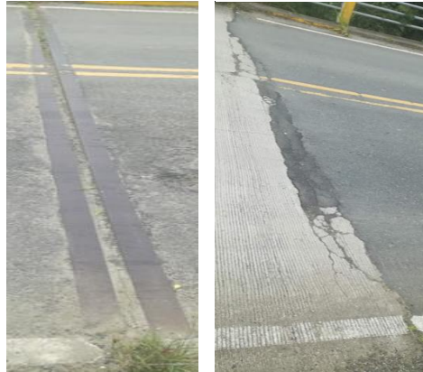
FOTOGRAFIA 3.3 Juntas cubiertas por capa asfáltica
