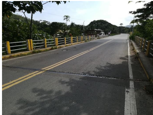
FOTOGRAFIA 3.1 Señalización al acceso y sobre el puente.
