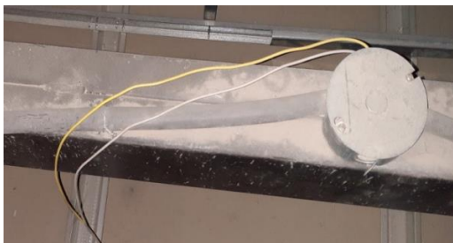
Figura 3.2. Revisión de instalaciones.
