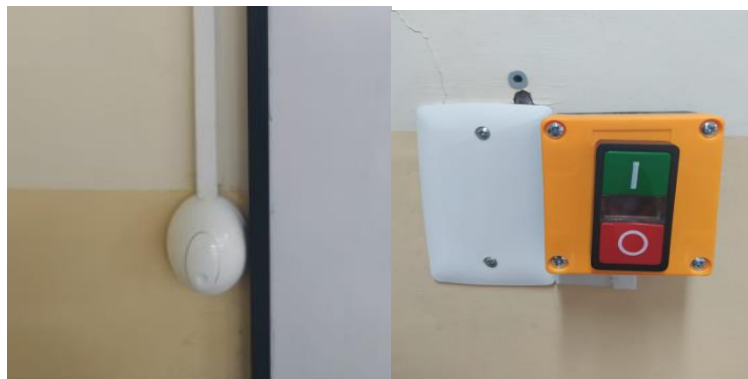
Figura 3.28. Empotrado del pulsador e interruptor. Fuente: Propia.
