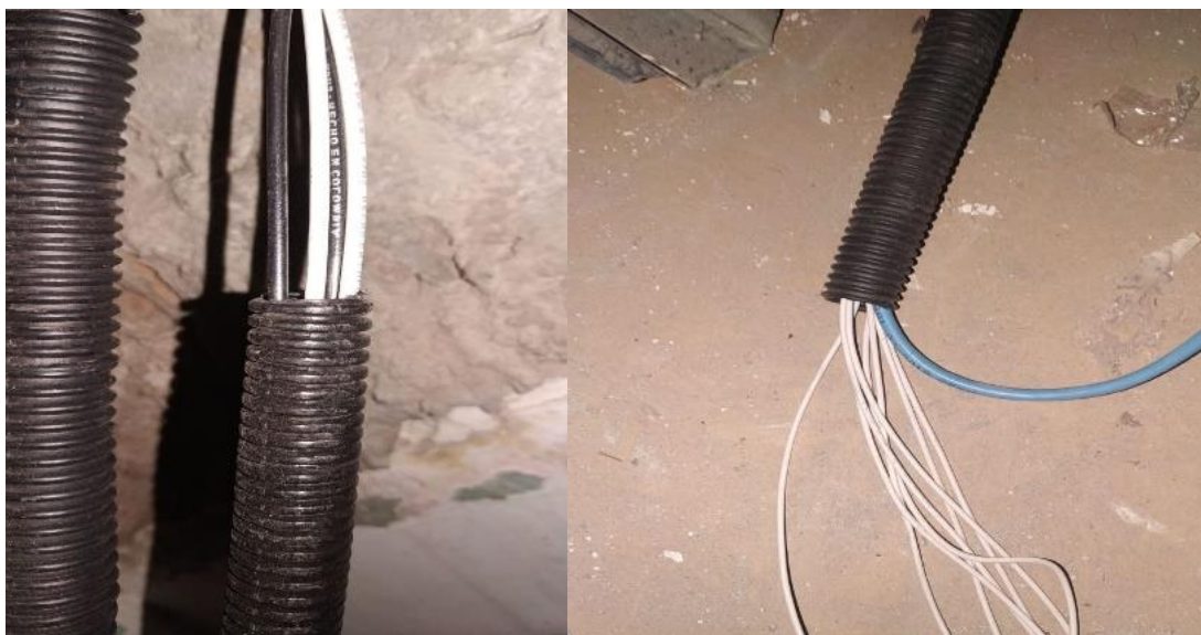
Figura 3.25. Paso del cable por la tubería. Fuente: Propia.
