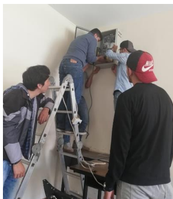
Figura 3.35. Empotrado de tableros. Fuente Propia.
