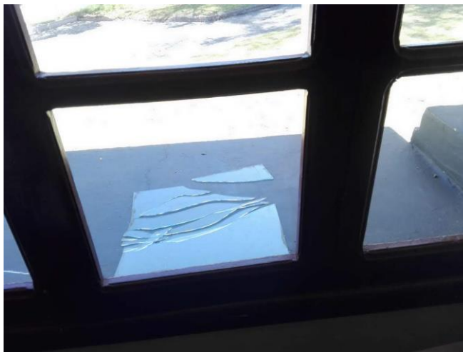
Figura 3.4. Ventana del aula 37. Fuente: Propia.
