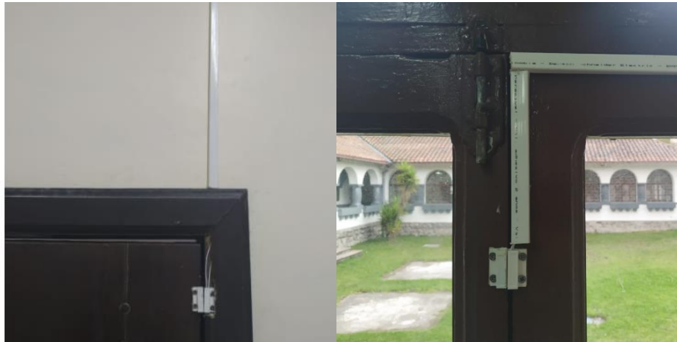
Figura 3.27. Instalación de sensores en puertas y ventanas.
