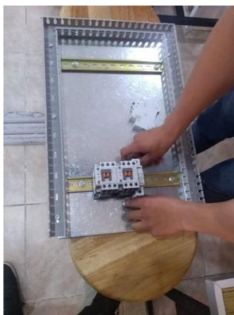
Figura 3.29. Estructura del tablero. Fuente: Propia.
