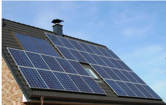
Figura 2.17. Estructuras coplanares [19]
