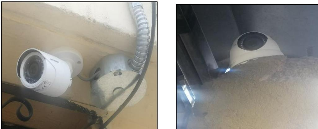
*Figura 3. 34 Cámaras instaladas del sistema CCTV*
