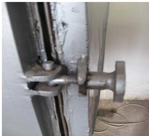
**Figura 5.3 Pernos de sujeción de la puerta.**
