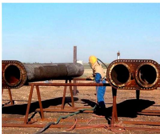
Figura 5.8 Tubería después de aplicar limpieza sobre una parte de ella.
