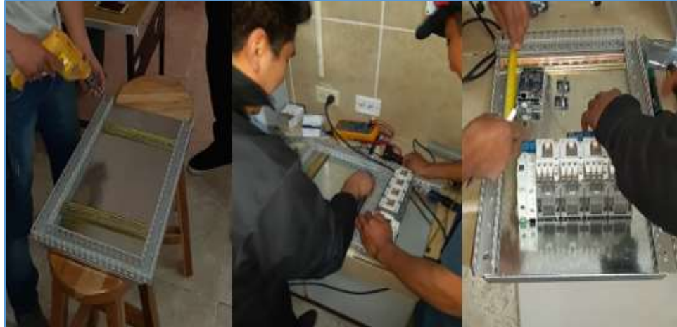
Figura 3.13: Instalación de componentes Fuente: Propia
