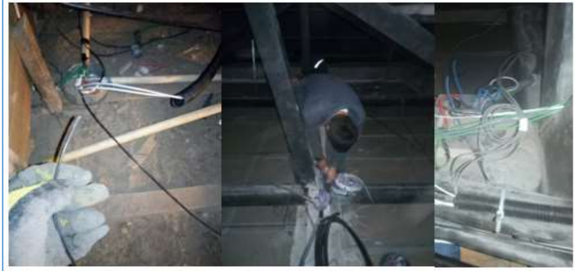
Figura 3.30: Paso de cable a través de tubería previamente instalada Fuente: Propia
