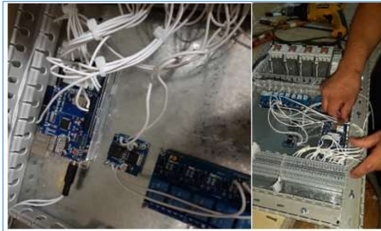
Figura 3.18: Implementación de cableado eléctrico interno Fuente: Propia
