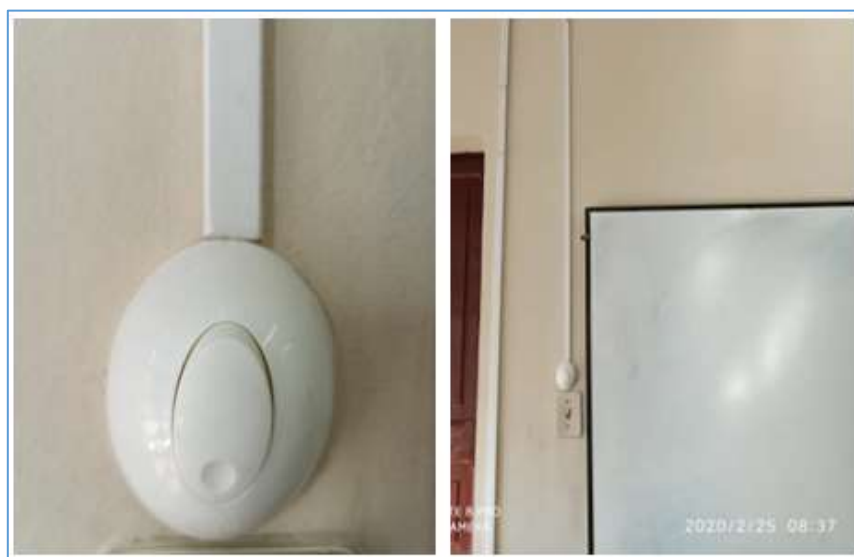
Figura 3.36: Instalación de interruptor para control de luminarias frontales Fuente: Propia
