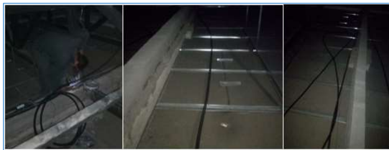
Figura 3.29: Instalación de conductos para cableado Fuente: Propia
