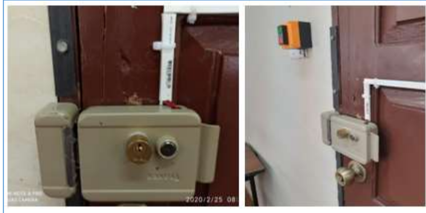
Figura 3.38: Montaje final de cerraduras eléctricas en cada puerta. Fuente: Propia
