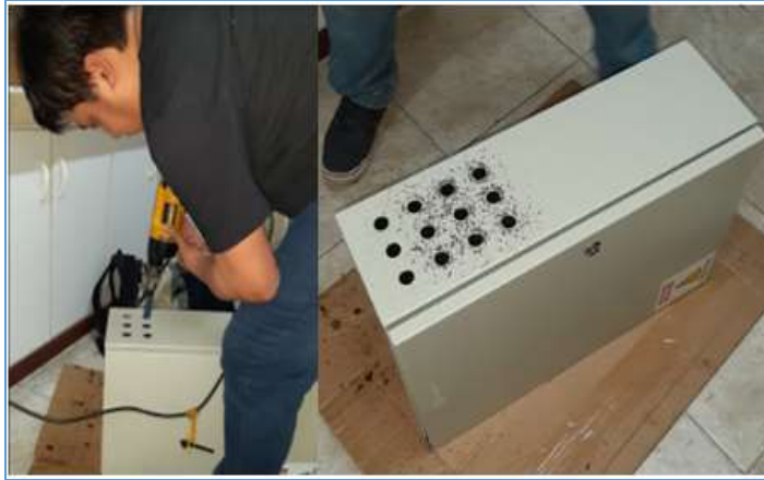
Figura 3.11: Preparación del gabinete metálico para construcción. Fuente: Propia
