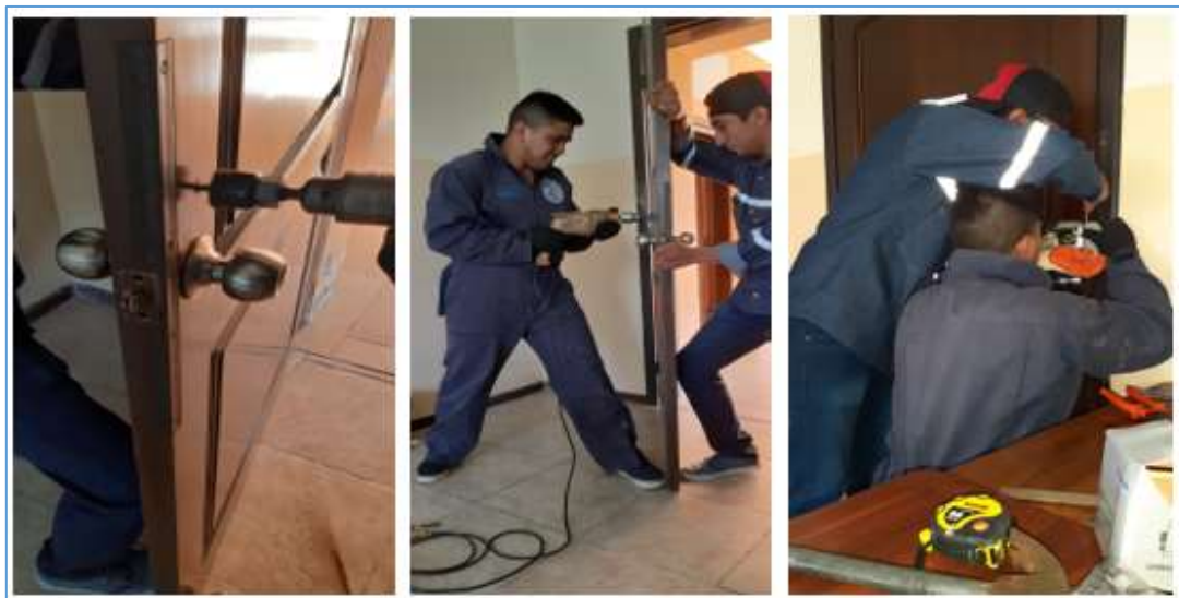
Figura 3.37: Proceso de montaje de cerradura eléctrica Fuente: Propia
