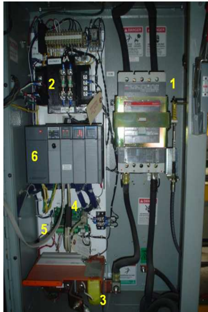
Figura 2.9 Componentes Principales Medar 3000 A.C..
