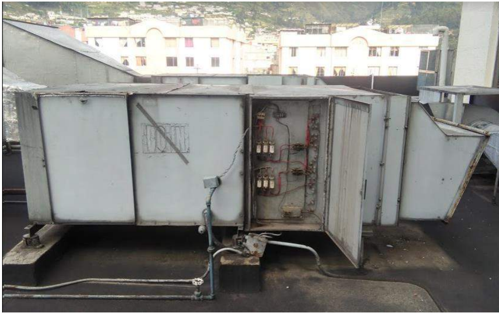
Imagen g. Unidad manejadora de aire (B) de los quirófanos 3er Piso. Fuente: Propia, Hospital Enrique Garcés.
