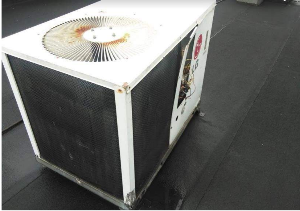
Imagen k. Acondicionador de aire de paquete individual Marca LG Modelo LK-0529CH.
