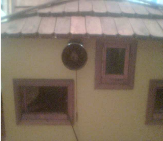
Figura 2.41 Colocación de la Sirena
