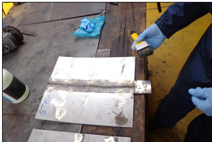
Figura 2.15. Aplicación de gel decapante en juntas soldadas. (Fuente: Propia)
