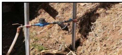
Figura 10 Muestreo en la conexión domiciliaria
