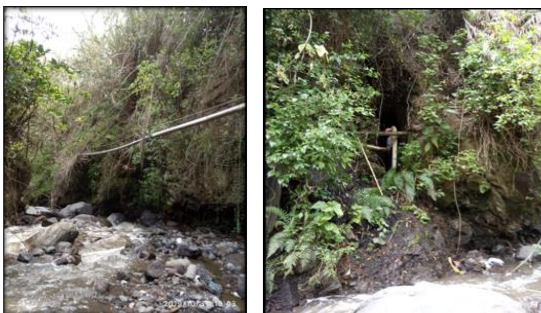
Figura 3.4 Muestra una vista frontal de la Vertiente H-Y.2 (Flores & Calderon, 2020).
