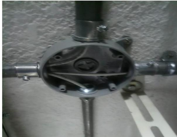
**Figura 3.20:** Caja de derivación tipo FS redonda
