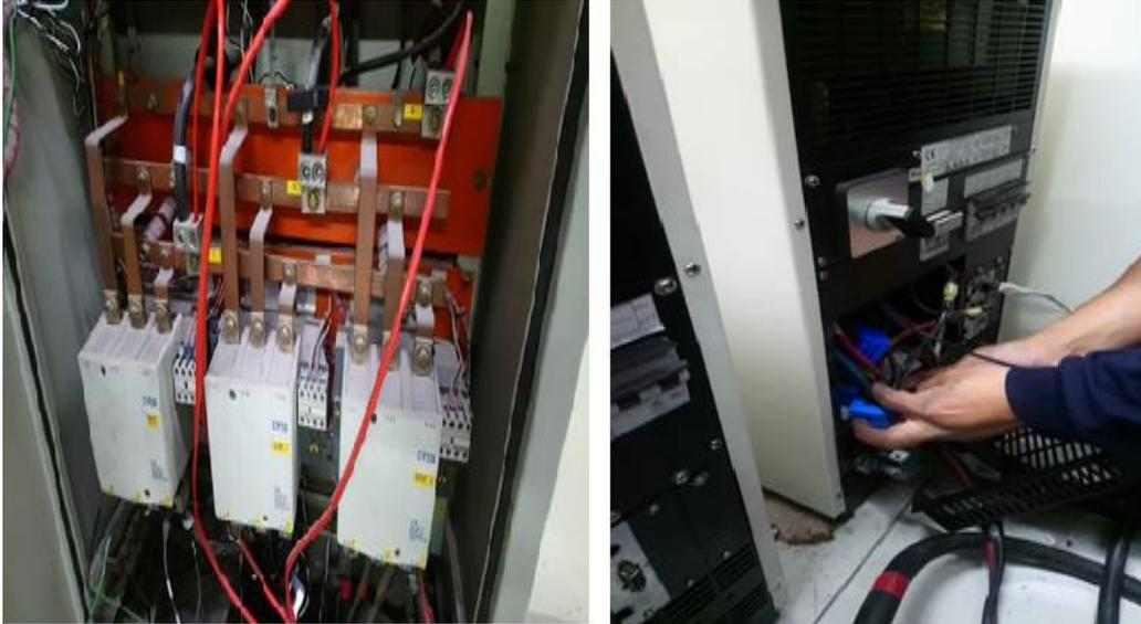
**Figura 3.26:** Instalación de sensores SCT
