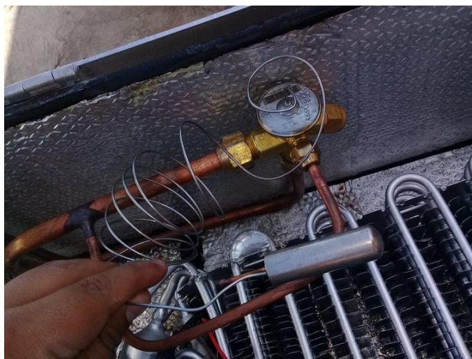
Figura 3.18. Válvula de expansión termostática y bulbo sensor. Fuente: Propia.
