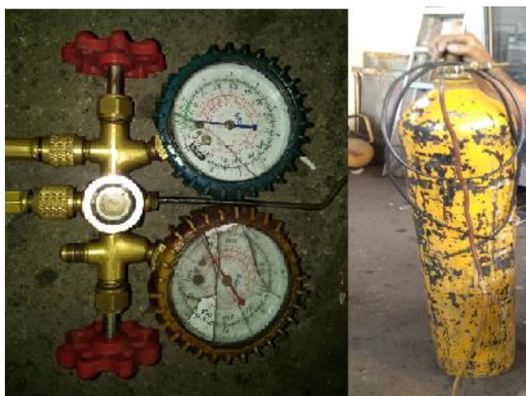
Figura 3.30. Prueba de fugas utilizando tanque de nitrógeno. Fuente: Propia.
