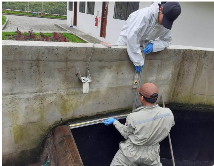
Figura 23. Medición del canal para la instalación
