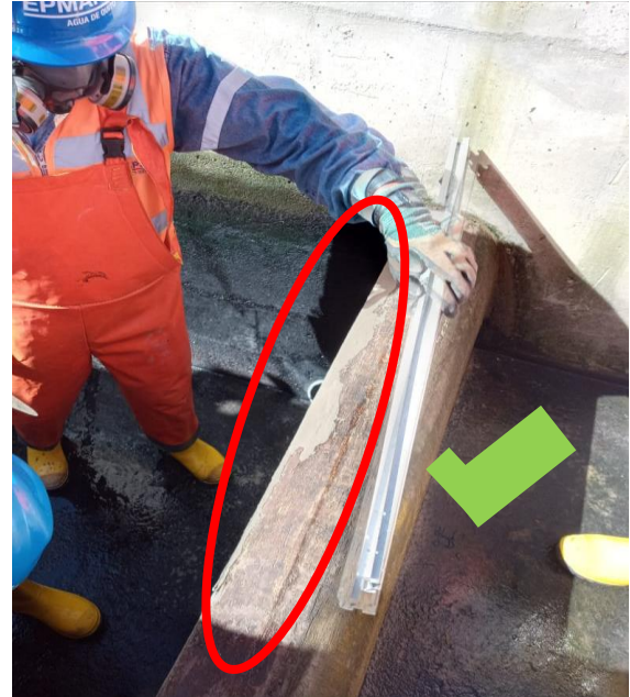
Figura 21. Adecuación del vertedero
