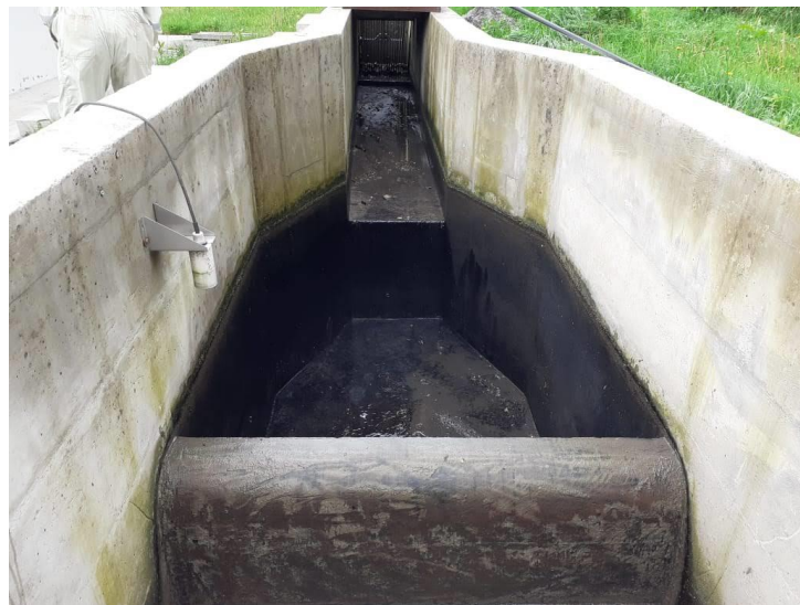
Figura 25. Verificación de la instalación del sensor
