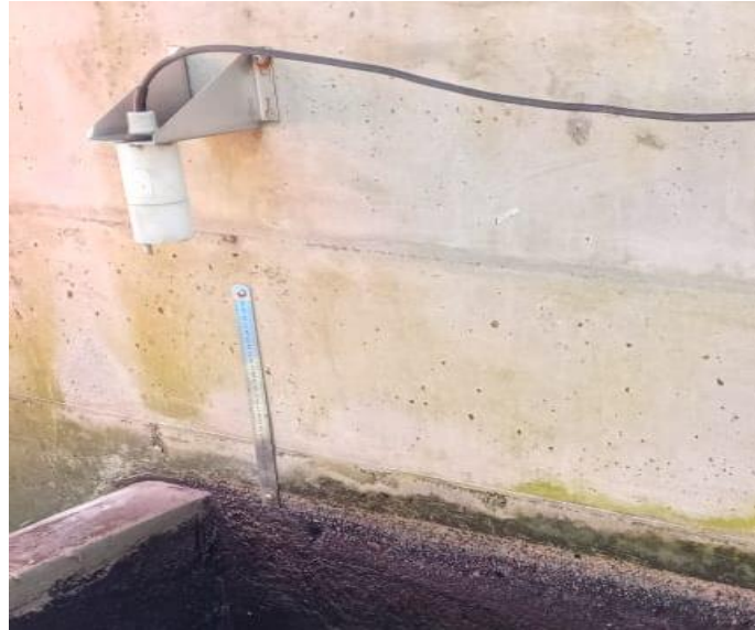
Figura 26. Anclaje de regla para medición del calado
