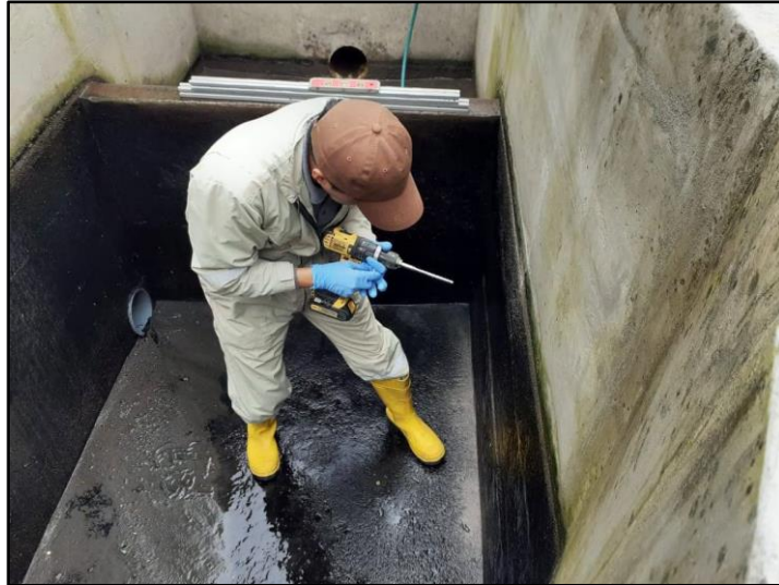
Figura 24. Realización de orificios para acoplar el sensor
