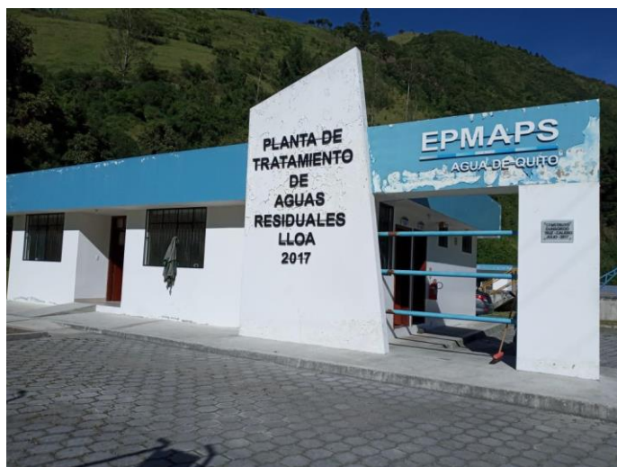
Figura 9. Ingreso vehicular y peatonal de la PTAR Lloa
