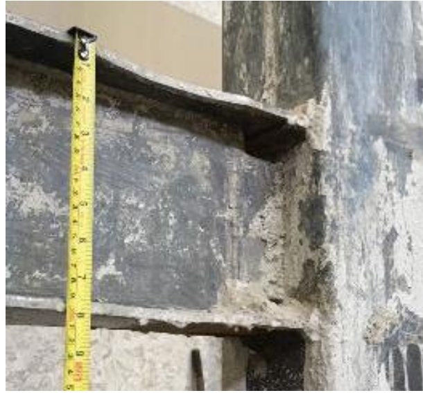
FIGURA 4.5 Altura de viga
