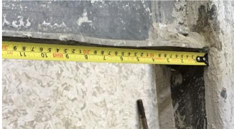
FIGURA 4.9 Conexión con sección reducida en vigas - modelo físico
