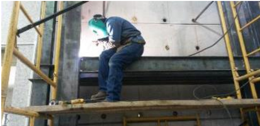
FIGURA 4.10 Ensamble de vigas a columnas
