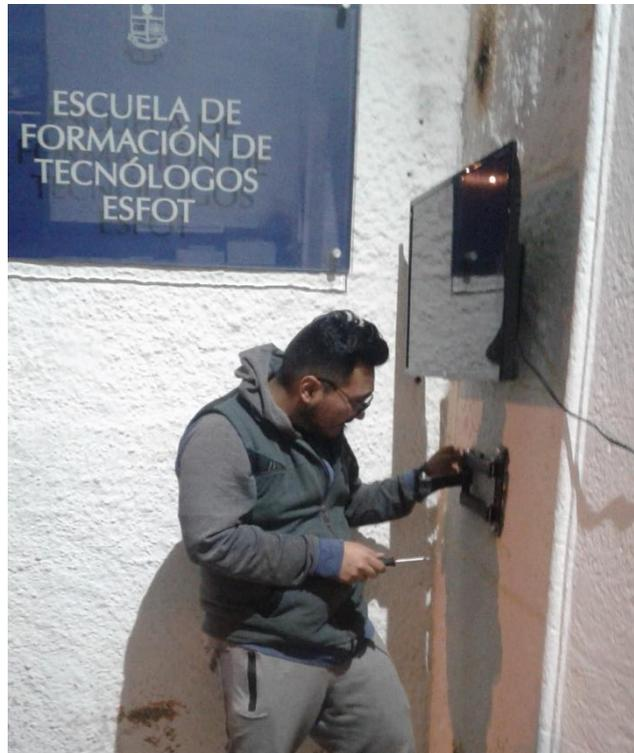
*Figura 3.36 Instalación de soportes y pantallas*
