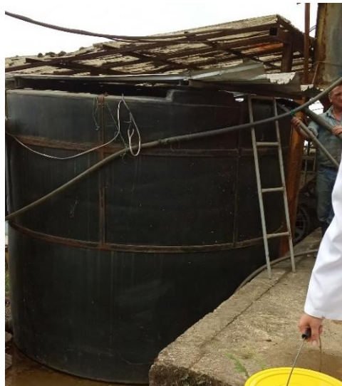
Figura 3. 3. Tanque de almacenamiento
