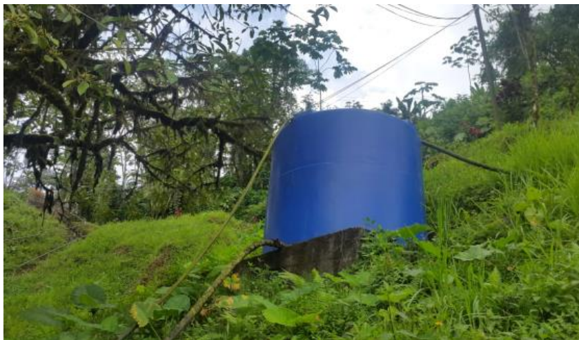
Figura 1. Tanque de reservorio de agua, el efluente del tanque se dirige mediante tubería a 3 comedores dispuestos en la parte alta, media y baja del campamento.
