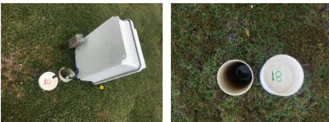
Figura 3 – Piezómetros instalados en el humedal Puglllohuma
