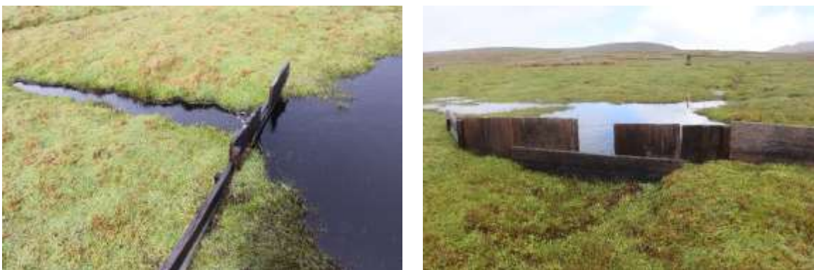
Figura 2 - Diques de madera instalados en el humedal Puglllohuma
